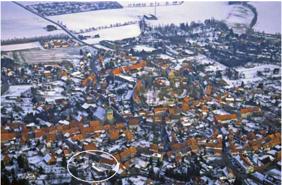
Luftaufnahme von Hornburg – im markierten Bereich stand die Synagoge.
